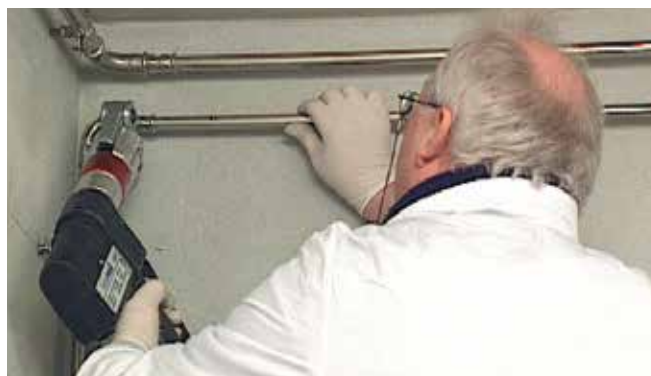
Bilde 32 – Utfør presskoblingen
