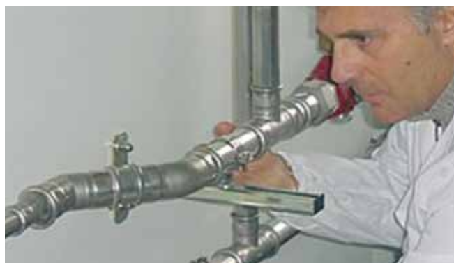
Bilde 33 – Kontroller presskoblingen
