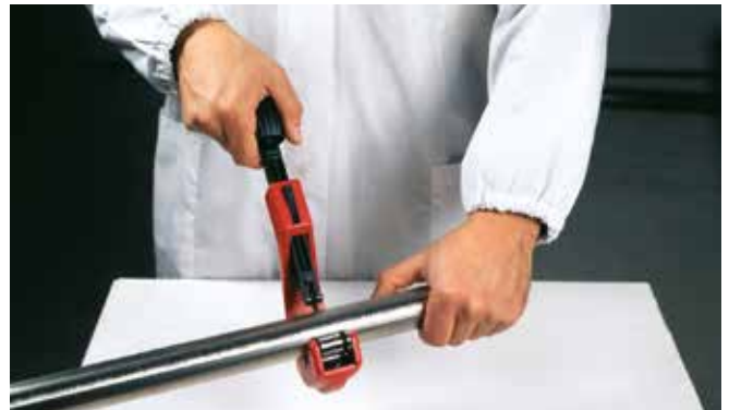
Bilde 25 – Tilkutting av rør
