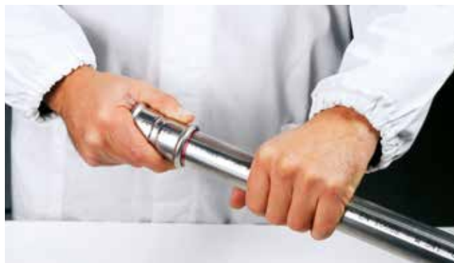
Bilde 31 – Sett røret inn i pressfittingen
