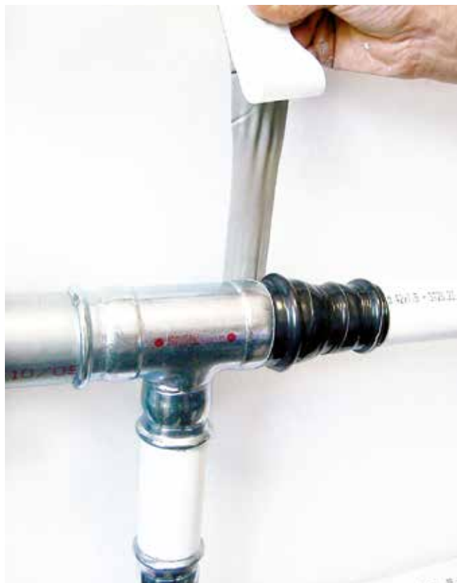
Bilde 35 - Beskyttelse av koblingene med butanoltape.
